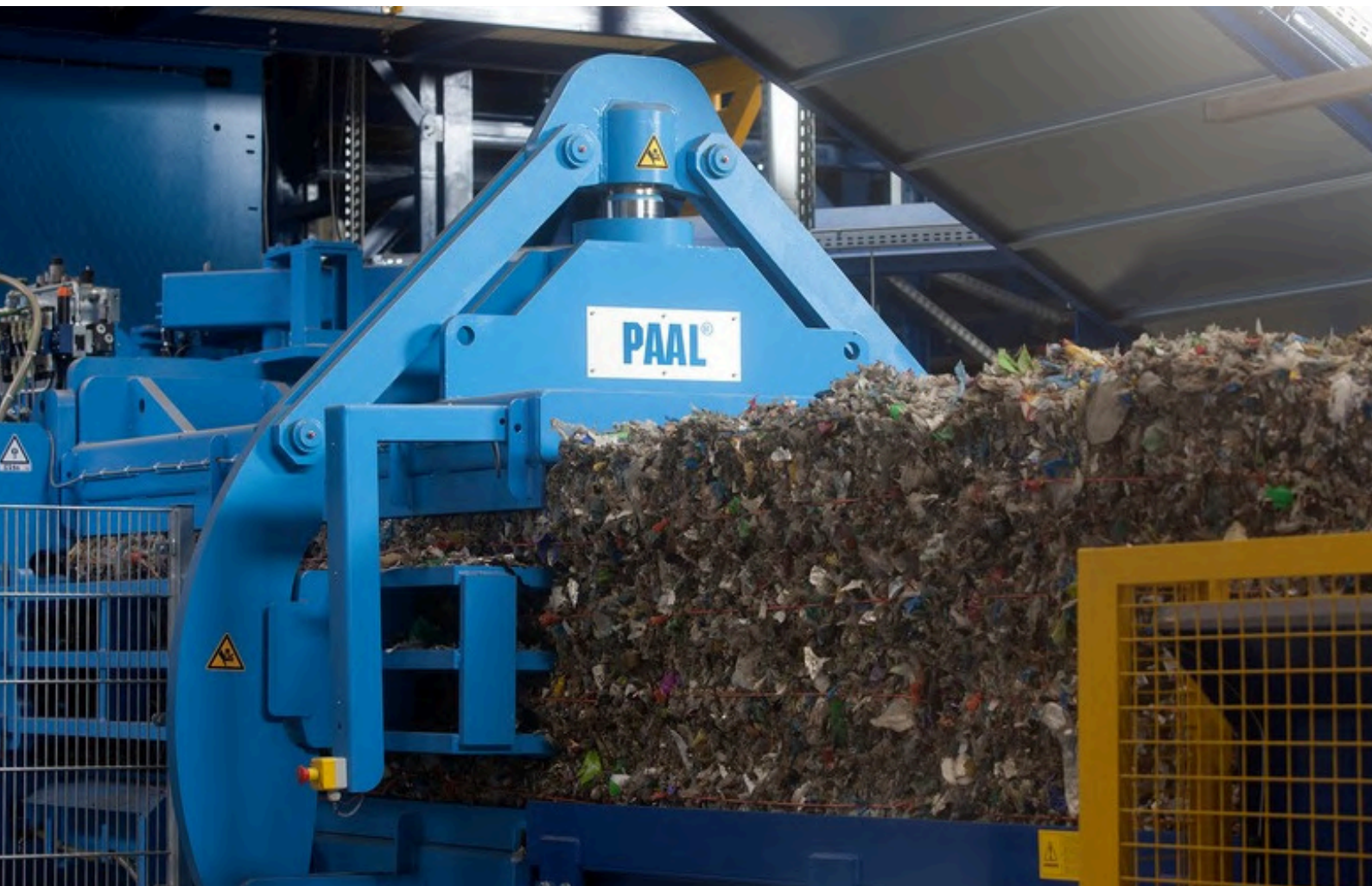
Zakład Mechaniczno Biologicznego Przetwarzania Odpadów w Zabrze FCC Śląsk.
