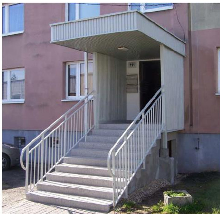
Remont schodów w budynku przy ul. Knosały 111 w Radzionkowie
